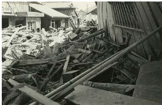
写真 72 第2室戸台風の被害（栖原）
