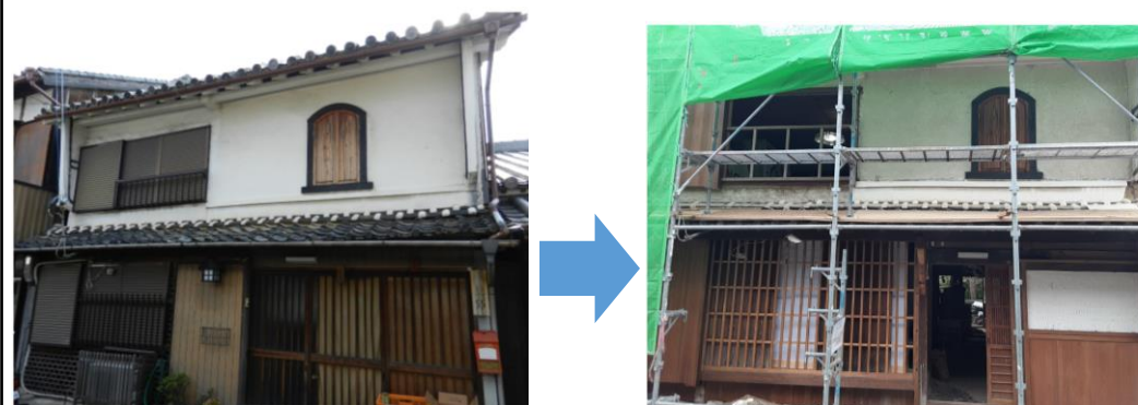
上野家住宅主屋修理工事（北町）
