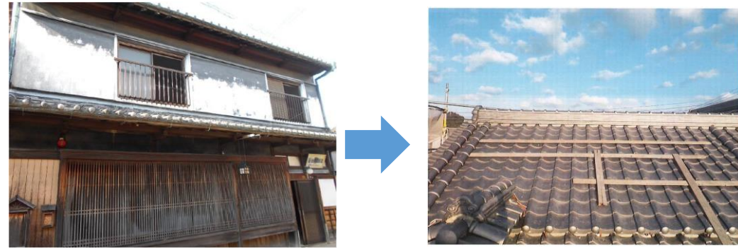
戸津井家住宅主屋修理工事（北町）
