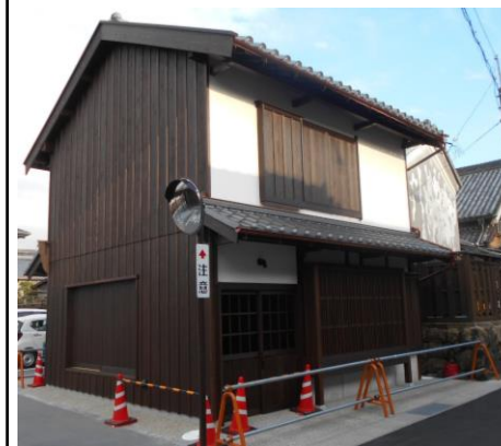
旧橋野家住宅主屋修景工事（北町）
