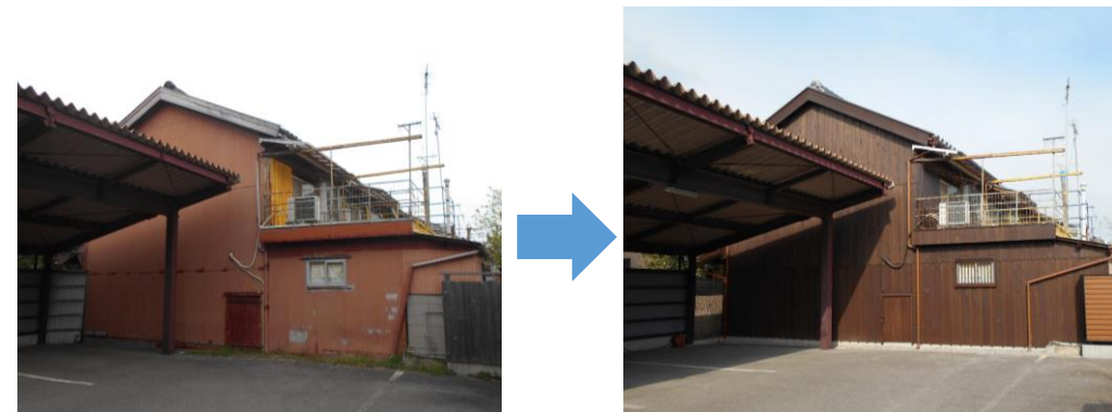
木下家長屋修理工事（北鍛冶町）
