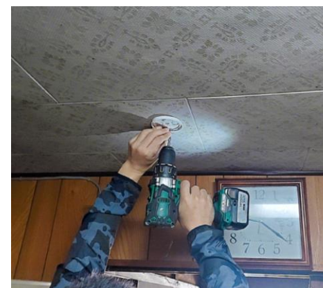
火災報知器設置の様子
