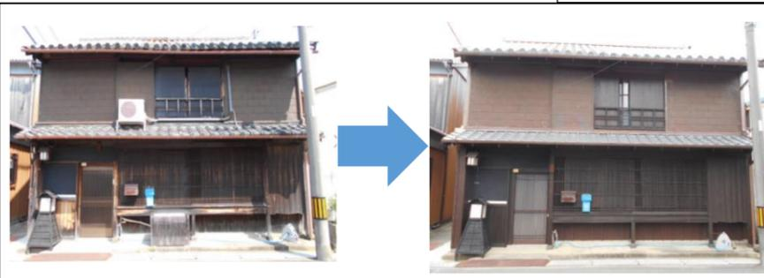
特徴的な銅製の壁材は、なるべく現状のまま残し、一部のみを張り替えました。雨樋は銅製に、建具は木製のものに変更しました。
