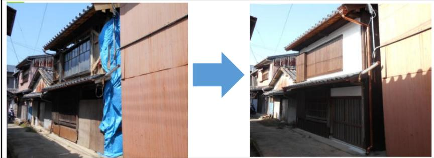
令和元年度に屋根瓦の葺き替えや、構造の補強工事を行い、令和2年度は土壁を塗り、板張りや漆喰塗りで仕上げ、部材の交換や補強工事を行いました。
