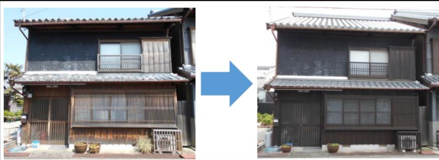
平成20年度に外壁や建具の工事を行いました。当時は健全な状態であった屋根が雨漏りしたので、屋根の工事を行い、瓦も葺き替えました。
