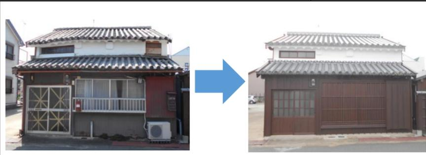
古い瓦を軒の手前に集め、その他の屋根瓦を葺き替えました。外壁のトタンを撤去し板壁に変更、また古い建具の痕跡に基づき復原しました。
