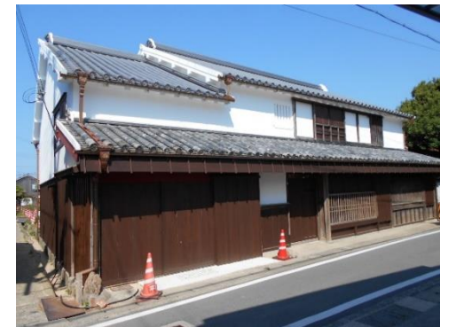
外観修理完成後の主屋
