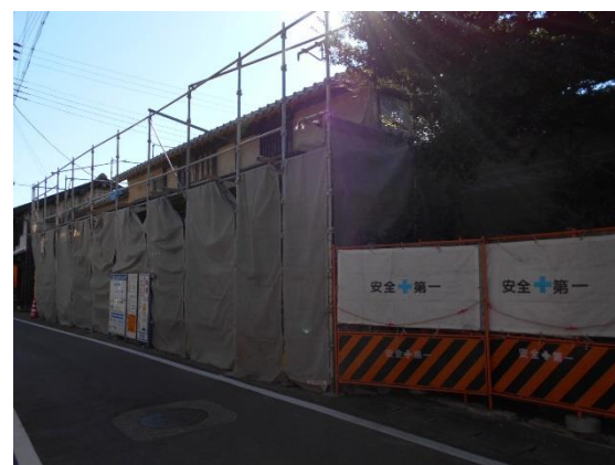
旧栖原家工事現場
