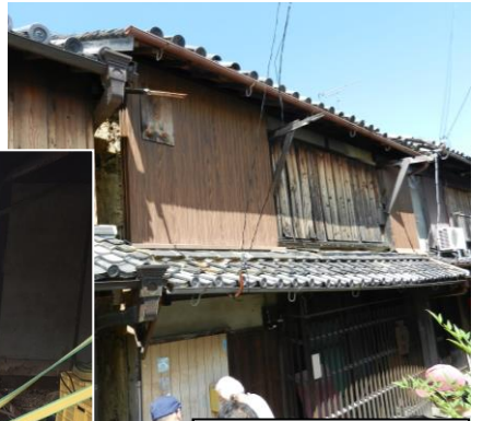
工事前の様子
