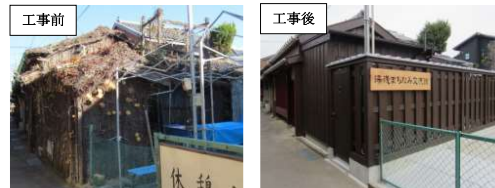
旧小川家住宅改修工事
