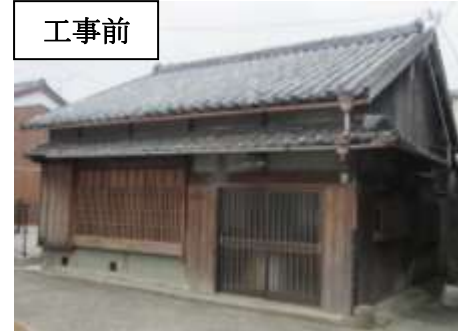
土岐家住宅主屋修理工事（北鍛冶町）
