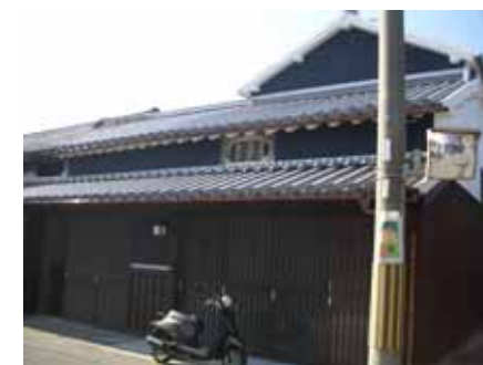
修理後(アフター)
